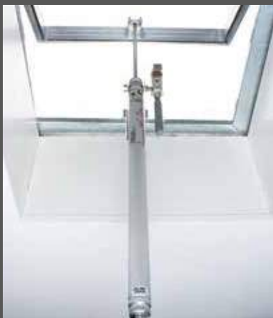
Su cupola con valvola termica
